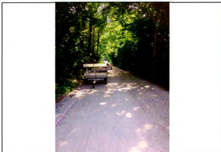
Gedeelte van de straat is afgezet, de stratenmakers volop aan het werk!
