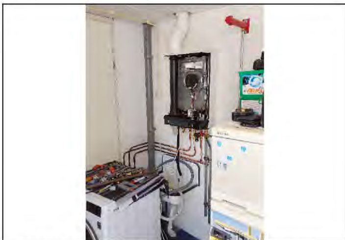
De cv hangt al voor het grootste gedeelte ook is de stormbeugel al geplaatst.
