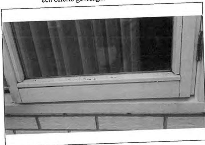
verf is aan het afbladeren
