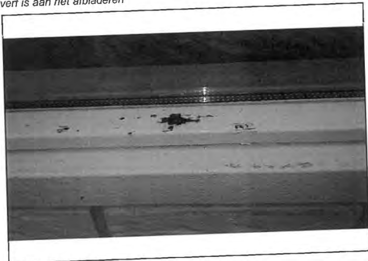
verf is aan het afbladeren
