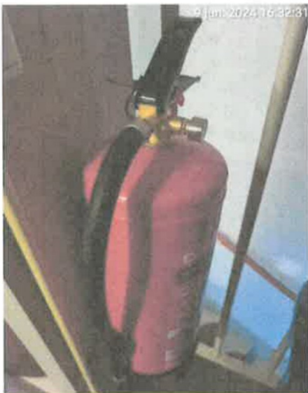
2e / blus / hangt & niet gekeurd / voldoet niet.
