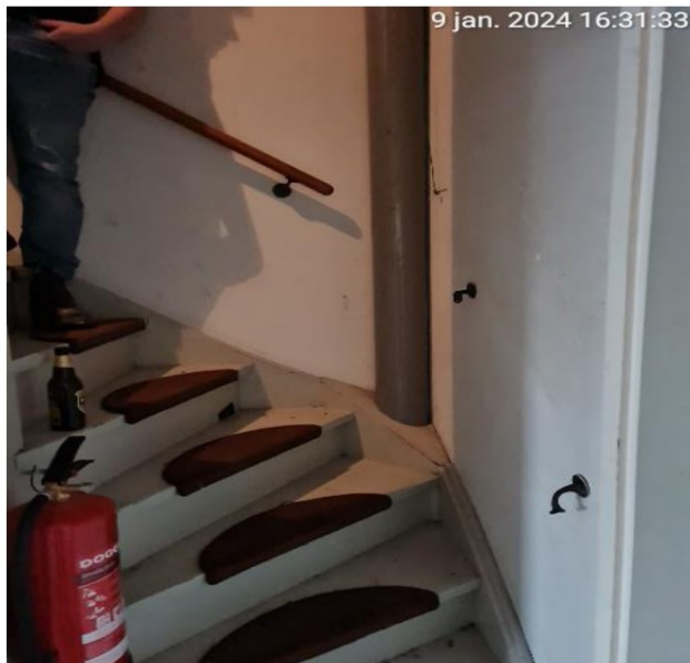
1 e / trap naar 2 e verd / leuning verwijderd / voldoet niet.
