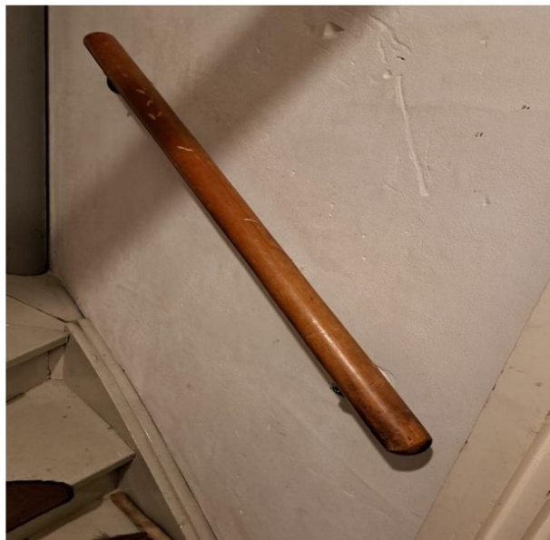
1 e / trap naar 2 e verd / leuning aangebracht / voldoet.
