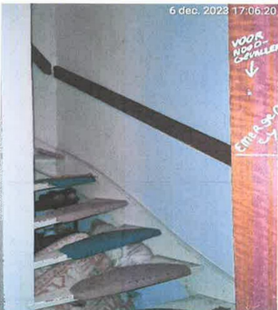
BG / trap naar 1 e / valbeveiliging aanwezig / voldoet.
