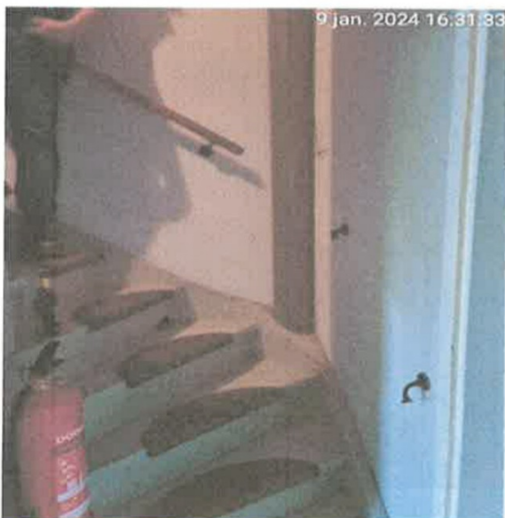
1° / trap naar 2° verd / leuning verwijderd / voldoet niet.
