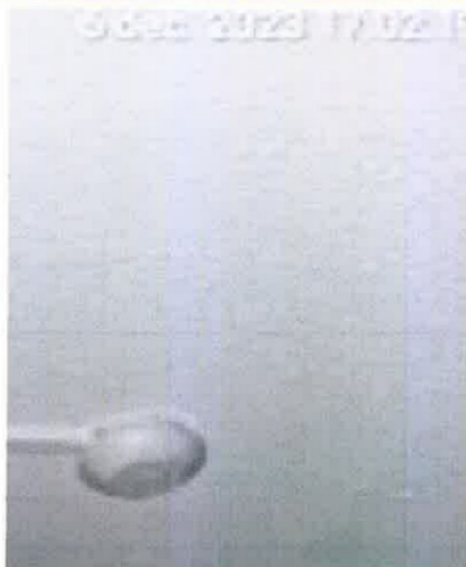
1e / overloop-1 / rookmelder aanwezig / voldoet.
