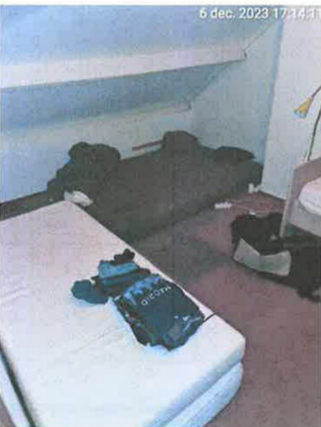
2° / slaapk-5 / vuurlast te hoog / verwijderen
