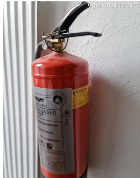
BG / blus / hangt & niet gekeurd / voldoet niet.
