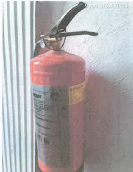
BG / blus / hangt & niet gekeurd / voldoet niet.
