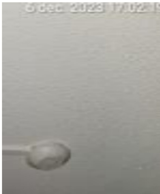
1e / overloop-1 / rookmelder aanwezig / voldoet.
