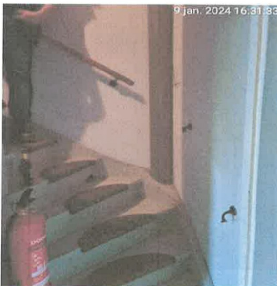
1° / trap naar 2° verd / leuning verwijderd / voldoet niet.
